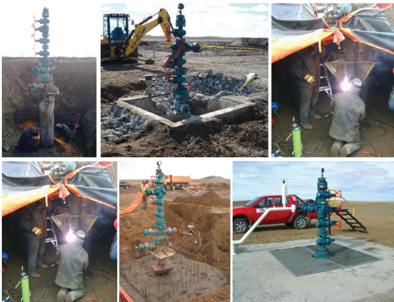
Figura 9. Remediación de elevación de casing mediante “Dado” de cemento. Ref. Wellhead Movement-Multi-String Casing Analysis”, Fontana (GeoPark), Rebas (Tenaris); SPE, noviembre 2011.
