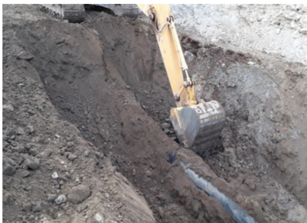
Figura 32. Re-excavación para colocar las abrazaderas.
