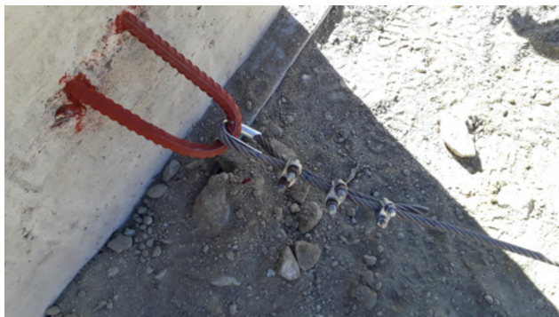
Figuras 36. Conjunto de elementos para amarrar el cable al muerto de anclaje.
