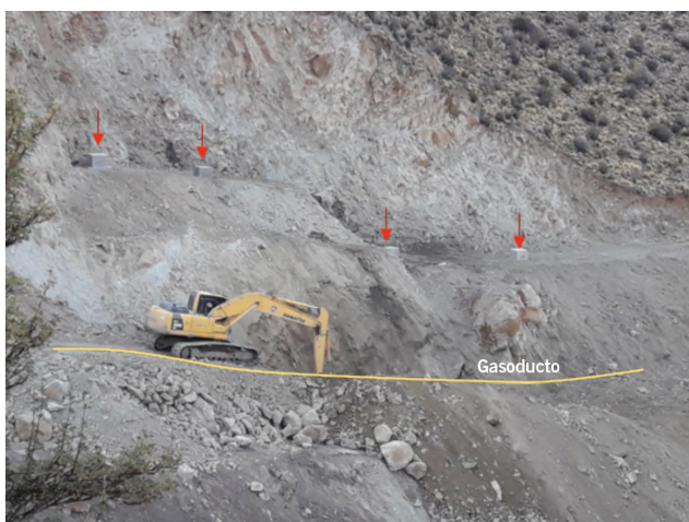
Figura 31. Vista panorámica de la disposición final de los muertos en el banco. Dos ellos en la parte superior del banco, y los otros dos, en la parte inferior. Debajo, en línea amarilla, la ubicación aproximada del ducto con la excavadora comenzando a excavar para la colocación de los cables y abrazaderas.
