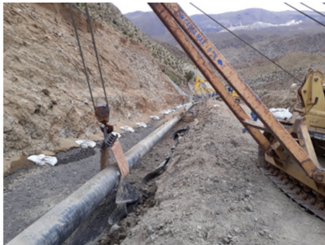
Figura 15. Inicio de los movimientos para desplazar la tubería a la nueva posición.
