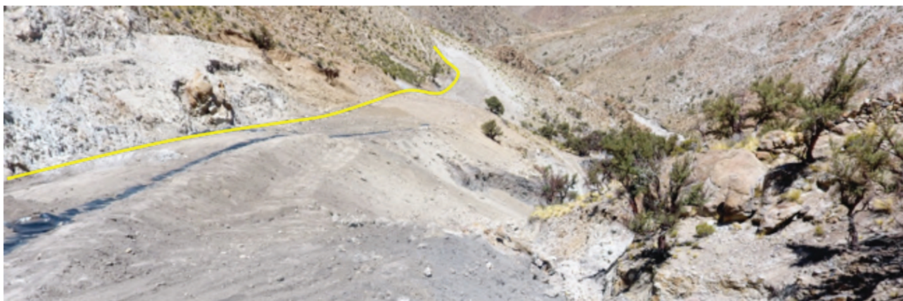
Figura 20. Gasoducto tapado y pista recompuesta con drenajes mediante geomembranas hasta retomar los trabajos de fijación final de la tubería al macizo.
