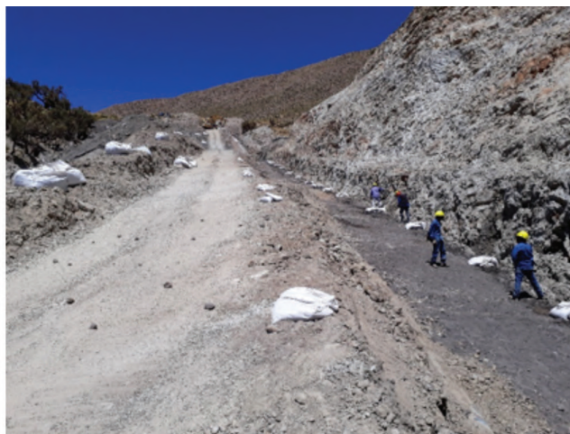
Figura 12. Preparación de la pista con el caño descubierto y medias cañas de protección para evitar caída de rocas durante la exposición de la tubería. Figura 13. Colocación de bolsas de polipropileno que marca el nuevo perfil de la tubería.
