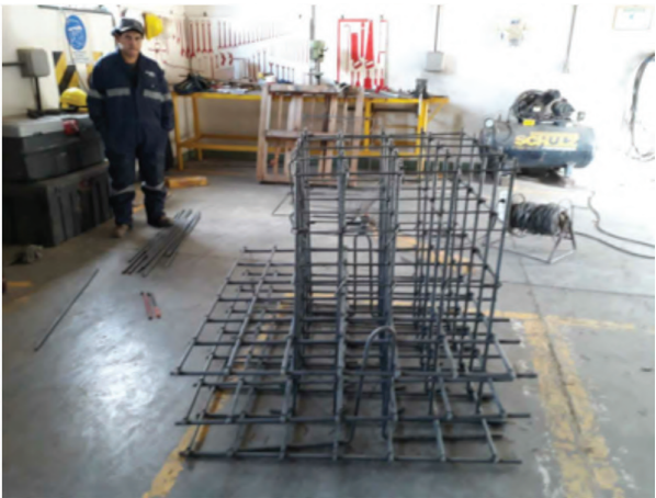
Figura 24. Construcción de la armadura.
