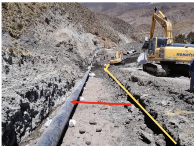
Figuras 16 y 17. Tuberías en la posición final luego del desplazamiento. Las flechas rojas indican la posición original donde se encontraba el ducto y hacia dónde fue movido.
