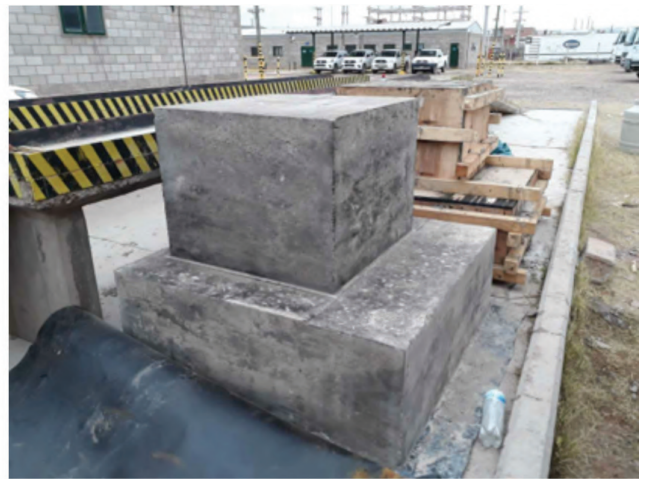
Figura 26. Desmolde y terminación final.
