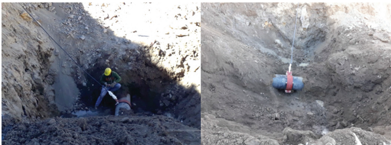
Figuras. 34 y 35. Diferentes ángulos de las abrazaderas con el cable tensor ya colocado.
