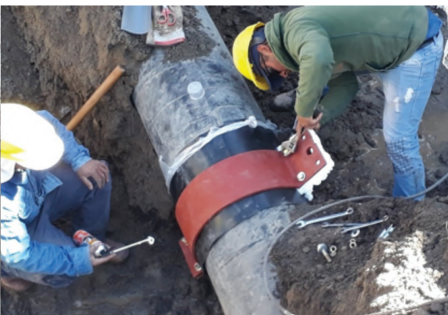
Figura 33. Colocación de la abrazadera.
