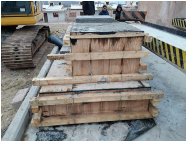
Figura 25. Encofrado y colado del hormigón.
