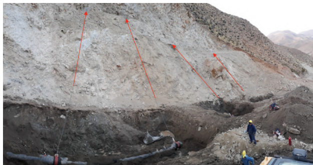
Figura 37. Disposición final de las abrazaderas con los cables tensores colocados.
