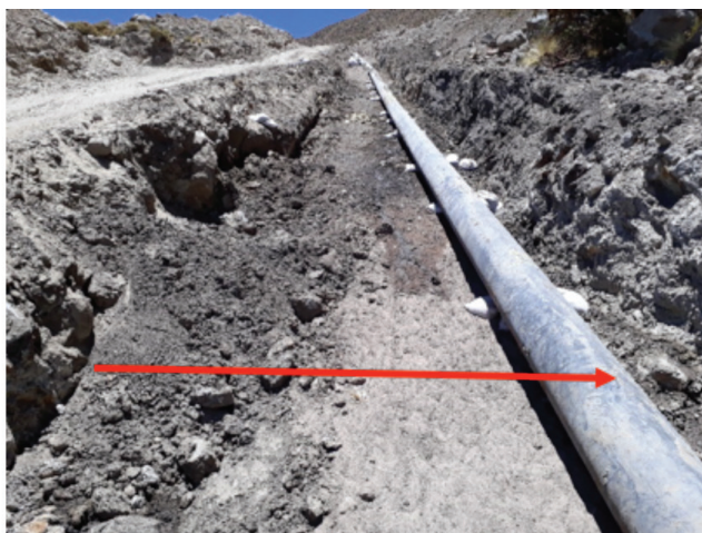
Figuras 16 y 17. Tuberías en la posición final luego del desplazamiento. Las flechas rojas indican la posición original donde se encontraba el ducto y hacia dónde fue movido.
