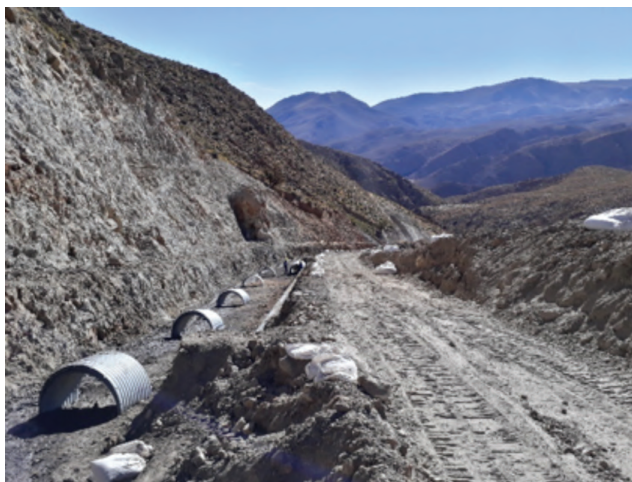
Figura 12. Preparación de la pista con el caño descubierto y medias cañas de protección para evitar caída de rocas durante la exposición de la tubería. Figura 13. Colocación de bolsas de polipropileno que marca el nuevo perfil de la tubería.
