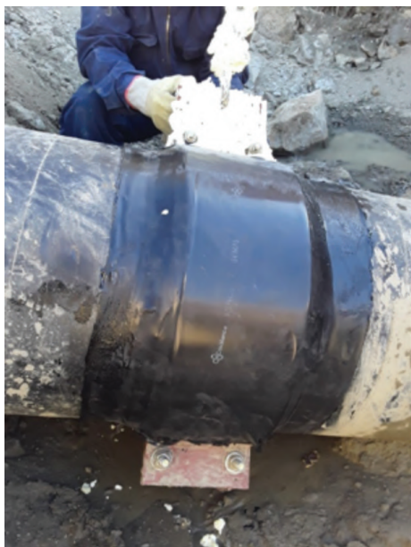
Figuras 38 y 39. Revestido de las abrazaderas con mantas termo-contráctiles, rock shield y espuma poliuretánica.
