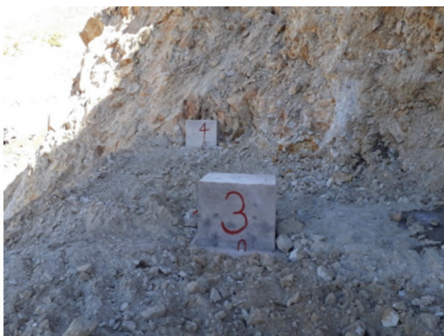
Figuras 29 y 30. Disposición final de los muertos, dos en la parte inferior del banco y dos en su parte superior.
