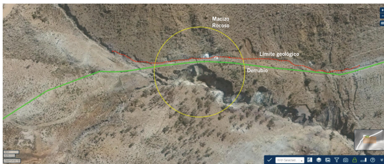
Figura 4. Imagen satelital de 2016 que muestra claramente la problemática de avance de la erosión de la barranca izquierda del cañón hacia la pared del macizo rocoso que esta subyacente. Se muestra el límite entre ambos materiales, en el medio, el ducto.
