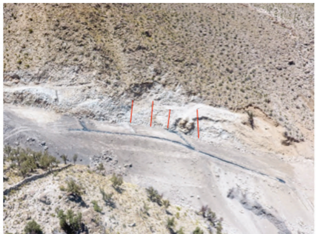
Figura 40. Colocado de material seleccionado sobre las abrazaderas. Figuras 41, 42 y 43. Relleno y adecuación final de la pista frente a las escorrentías.
