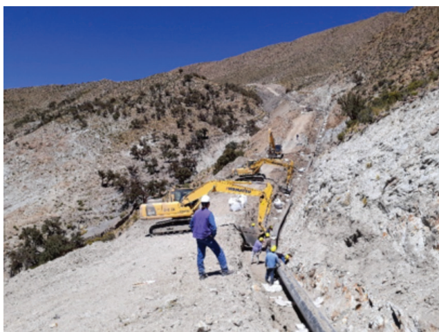
Figuras 18 y 19. Panorámicas donde se observan los 440 m de tubería destapada y alineada en el nuevo perfil.
