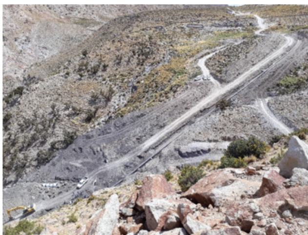
Figuras 18 y 19. Panorámicas donde se observan los 440 m de tubería destapada y alineada en el nuevo perfil.
