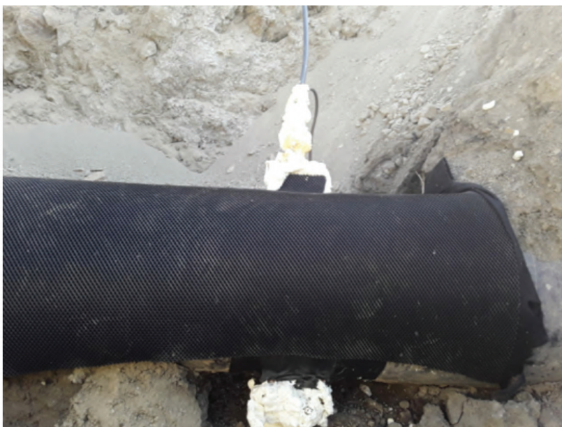
Figuras 38 y 39. Revestido de las abrazaderas con mantas termo-contráctiles, rock shield y espuma poliuretánica.
