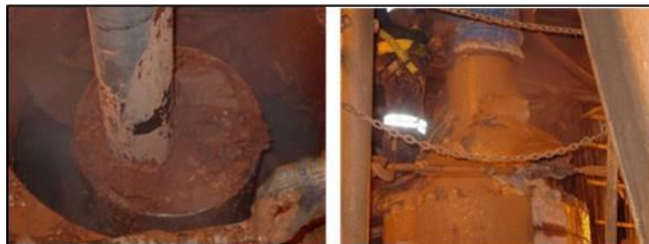
Figura 9. Anillos de arcilla en boca de pozo.
