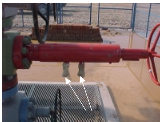
Figura 7: Sensores de fin de carrera de un actuador hidráulico
