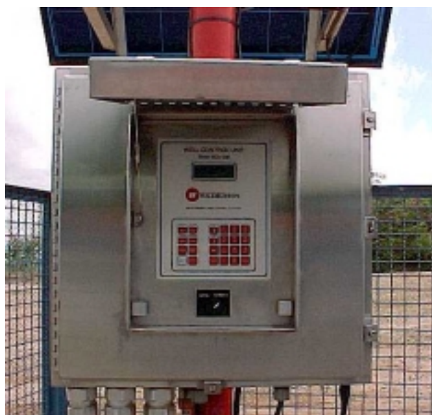
Figura 3: Well Control Unit (WCU) o Controlador Electrónico de pozo
