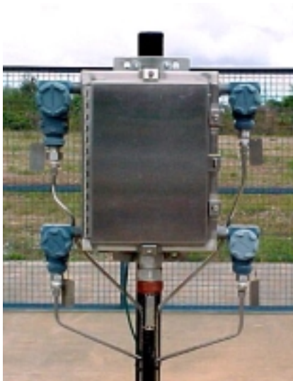
Figura 4: El Instrument Junction Box es una caja de acero inoxidable que contiene a los sensores de presión: casing, línea, tubing, e inyección de químico
