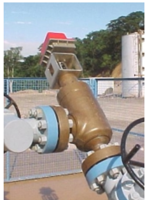
Figura 5: El choke que se muestra aquí tiene un orificio máximo de 160/64"
