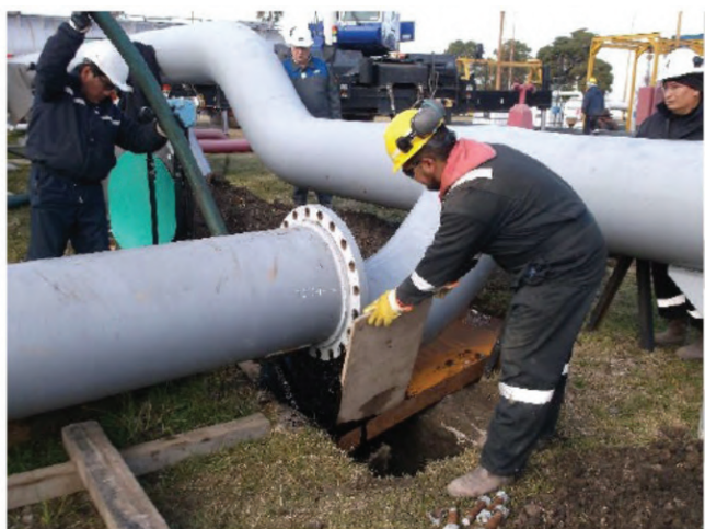
Figura 5. Hidrocarburo negro viscoso que filtra del niple de 24" durante los trabajos de desconexión en el accesorio T (izquierda); residuo de hidrocarburo de donde se extrajeron las muestras 2, 3, 4 y 5 (derecha).
