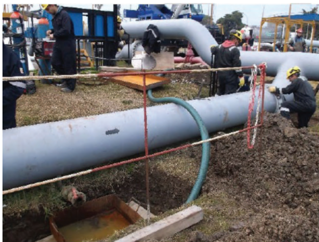
Figura 4. Drenaje que fue empleado para recolectar la muestra de agua (Muestra 1).
