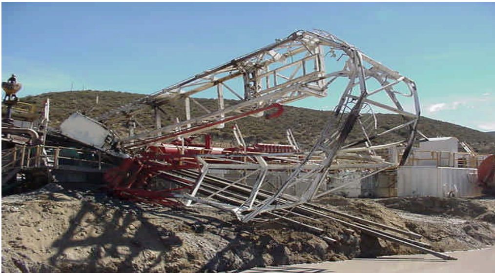
Figura 12: Equipo IDECO luego de la ruptura, accidentes evitables.
