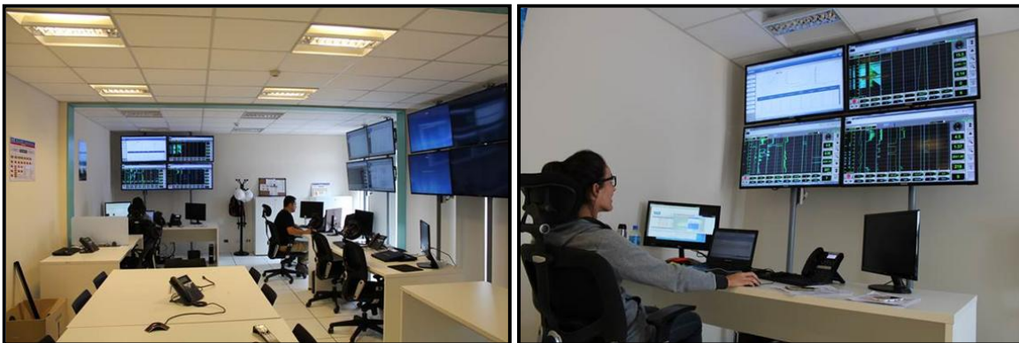
Figura 16. Centro de Operaciones Remotas en las oficinas de Loma Campana.
