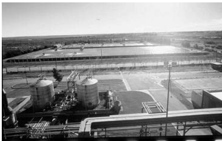
Figura 11 - Área de tratamento d'água da Refinaria Ricardo Eliçabe (Argentina)
