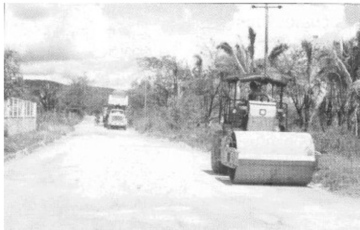
Figura 13 - Pavimentação em Melgar (Colômbia)
