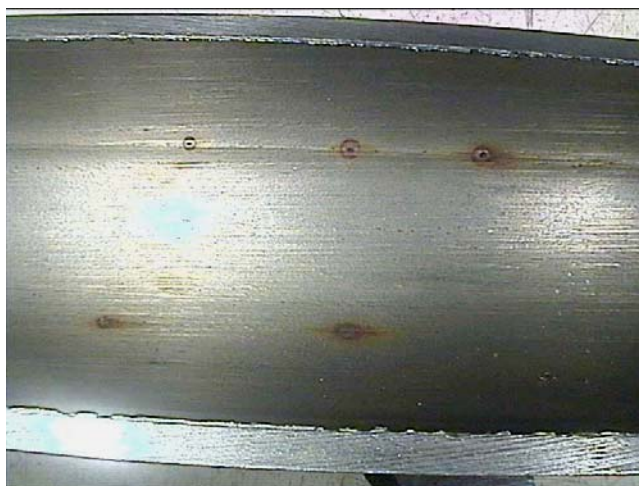
Foto 5: picadura en el interior de un Tubing 13Cr en los “canales” dejados durante los trabajos con cable
