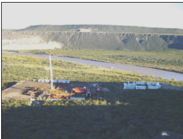
Equipo perforador y campamento CHN-xp3.
