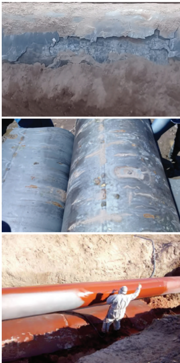
Figura 14. Recoating realizado en segmentos con revestimiento 3LPE muy degradado.
