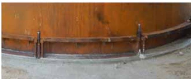
Figura 25. Fotografía de grouting y sellado finalizado.
