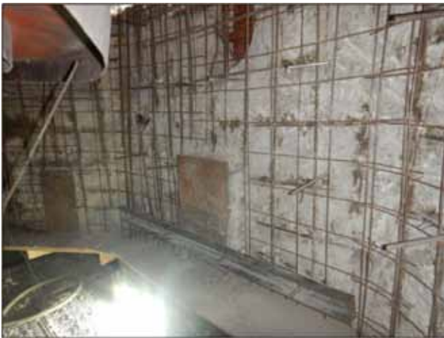
Figura 19. Fotografía desde interior de refuerzo de armaduras y malla.
