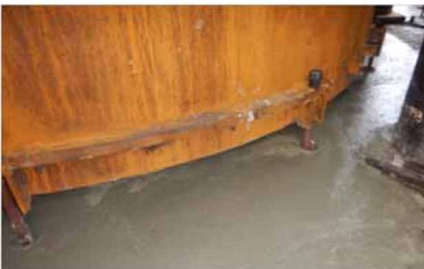
Figura 24. Fotografía de hormigonado terminado.
