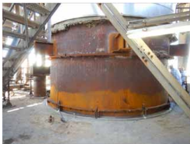
Figura 27. Fotografía exterior de trabajo terminado.
