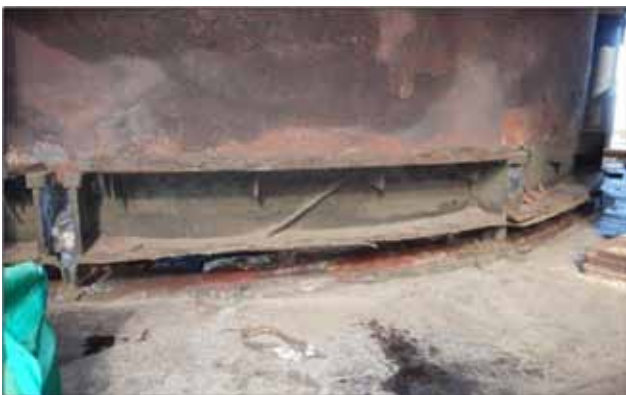
Figura 16. Fotografía de cámara elevada.
