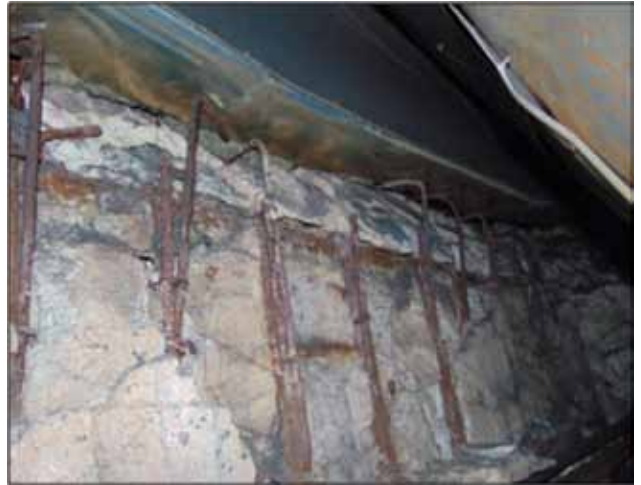
Figura 9. Pared interior de la losa de soporte.
