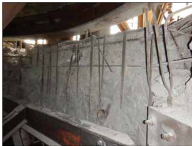
Figura 17. Demolición de hormigón en malas condiciones.
