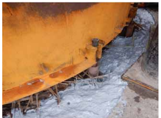
Figura 22. Fotografía de colocación de puente de adherencia.
