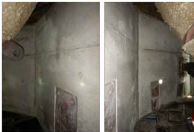
Figura 26. Fotografías interiores de trabajo terminado.
