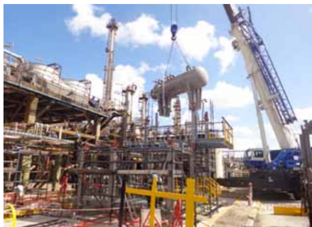
Figura 16. Montaje del recipiente acumulador de la PFU.
