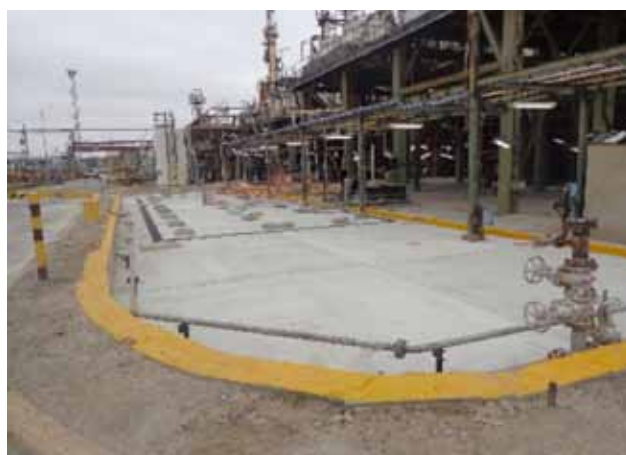
Figura 14. Construcción de nueva platea para la PFU.
