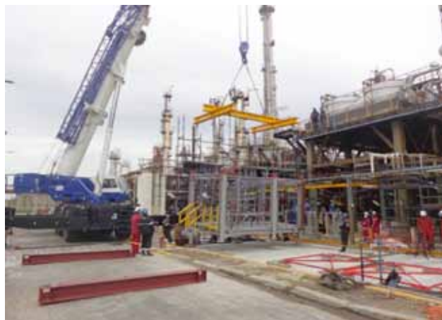
Figura 15. Montaje del primer módulo de la PFU.
