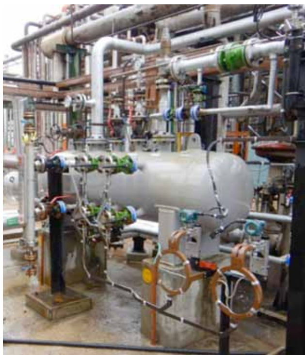
Figura 4. Evaporador de propano E-2101.
