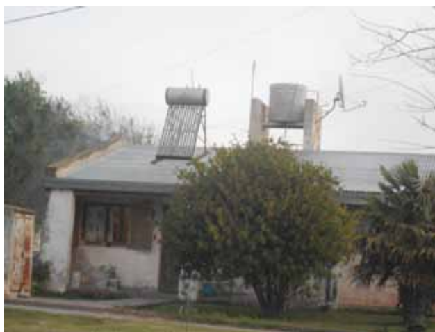
Figura 7. Vivienda rural equipada con termotanque solar instalado por los vecinos, De la Gama, Partido de González Chávez, provincia de Buenos Aires, 2015. Como se aprecia, tanto su orientación (casi vertical) como su orientación no son las adecuadas, en consecuencia el equipo no cumple su objetivo.
