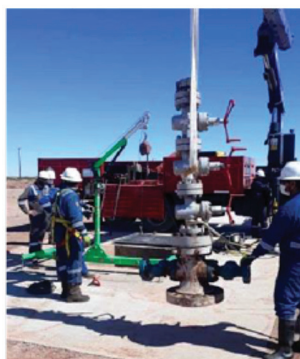
Figura 2. Sello interno de fuga en colgador de Csg de 5 ½".
