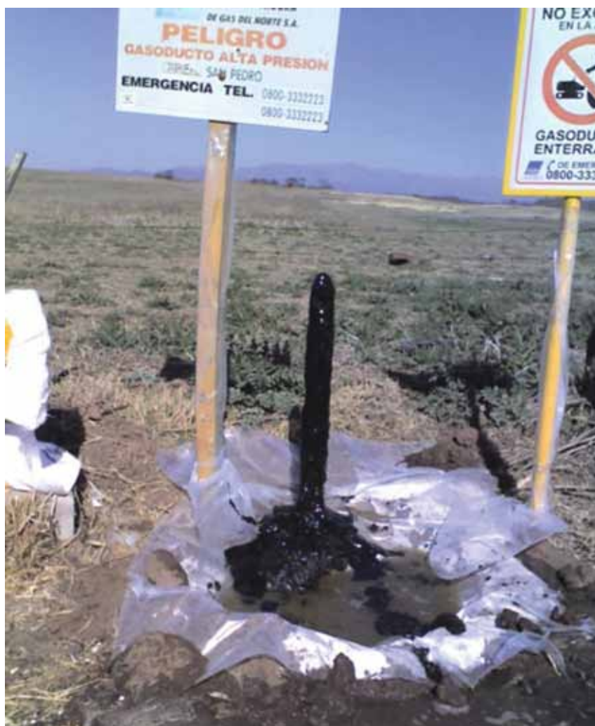
Foto 6. Etapa final del llenado con cera microcristalina.
