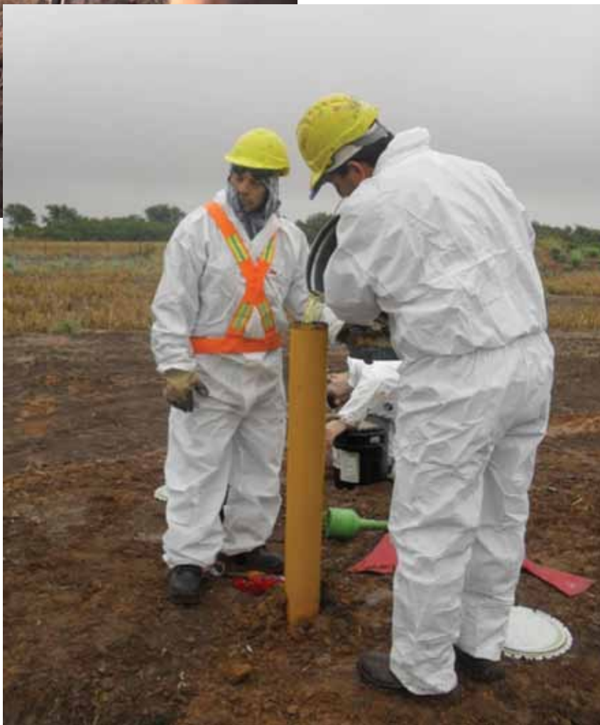
Foto 4. Vertido del líquido inhibidor de corrosión y bactericida.
