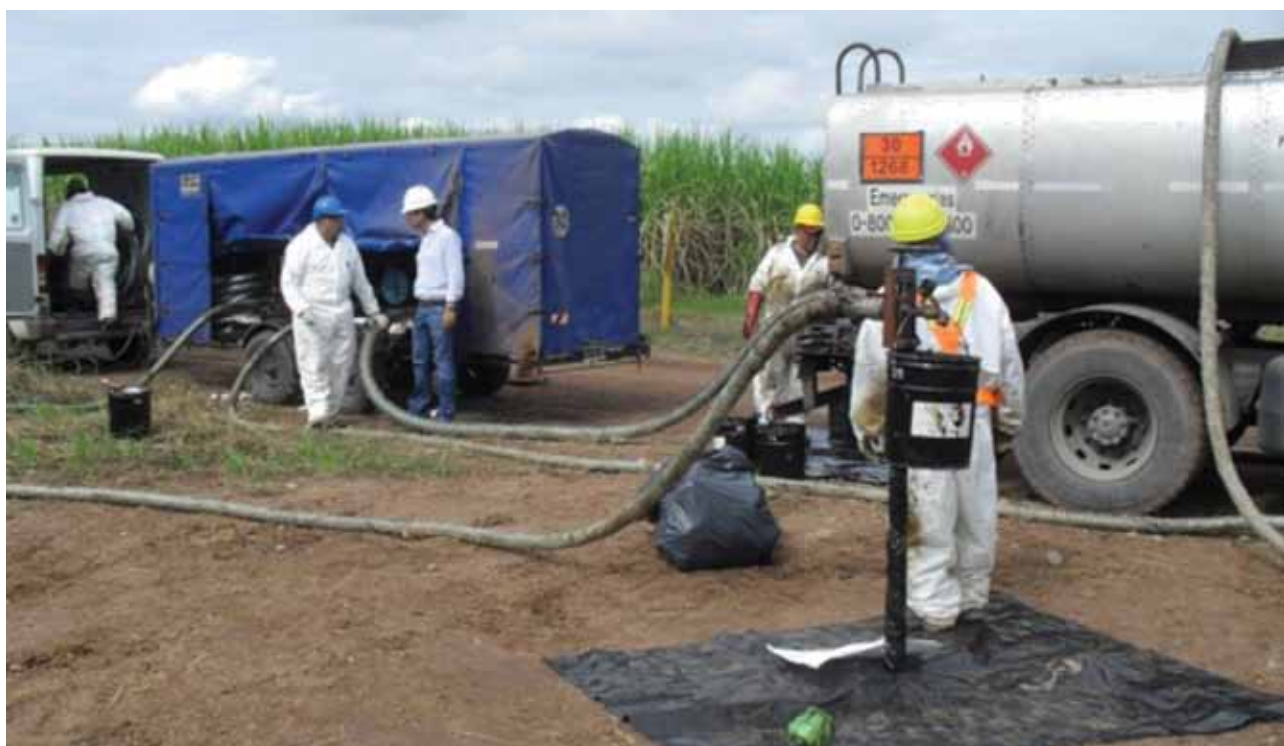
Foto 5. Inyección de la cera microcristalina.
