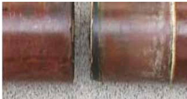
Figura 27. Muestra 2, posensayo. Separación de junta.
