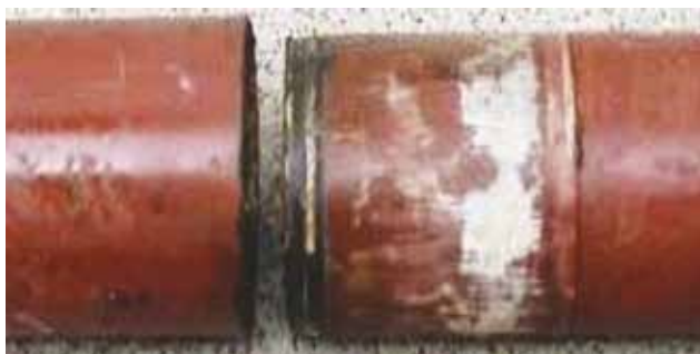
Figura 25. Muestra 1, posensayo. Separación de la junta.
