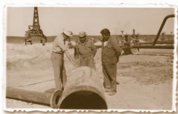
Armado Planta rebombeo Km 51, en el oleoducto "El medanito, Allen".
