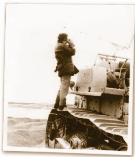
Obra del lanzamiento de la cañería submarina en la Bahía de San Sebastián.
