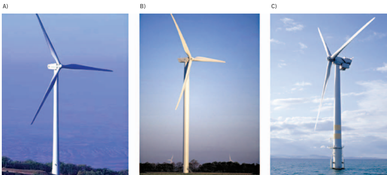
Figura 1. General Electric: A) Potencia: 1,5MW. Diámetro de la hélice: 70,5 / 77 / 82,5m. B) Potencia 2,5 / 3,0MW. Diámetro de la hélice: 90 / 94 / 100m. C) Potencia: 3,6MW. Diámetro de la hélice: 104 / 111m.
