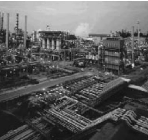
Figura 1. Planta de Síntesis de Destilados Medios de Shell (SMDS) en Bintulu, Malasia.
