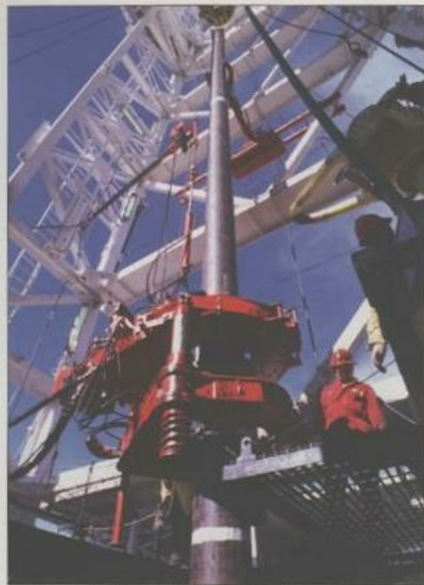
Entubación con el StabMaster , Pushmaster , Hydraklok y llave con puertas automáticas.
