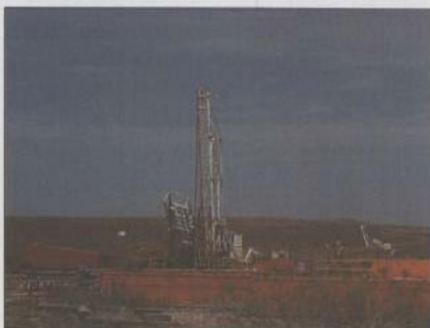
Figura 2. Equipo IDECO con mástil Cardwell KV 250 luego de la ruptura.
