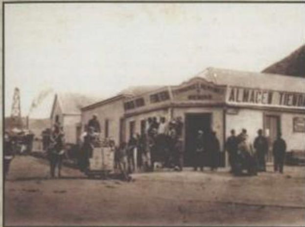
Una imagen de comienzos del siglo XX. Al fondo la primera torre de perforación. 1903 (circa)
