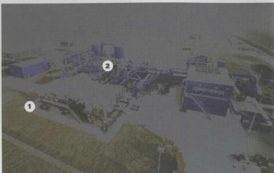
Figura 3. Más pequeño y mejor para el medio ambiente, el Twister (1) instalado en Barendrecht, Países Bajos, es más compacto que el proceso tradicional (2), una válvula Joule Thompson con inyección de TEG.
