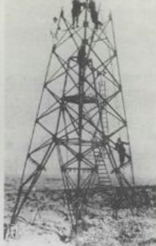
Torre de perforación y servicio (Cacheuta, 1886).
