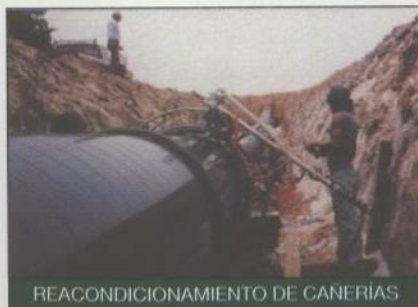
REACONDICIONAMIENTO DE CAÑERÍAS
