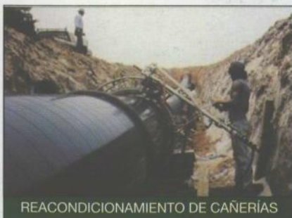
REACONDICIONAMIENTO DE CAÑERÍAS
