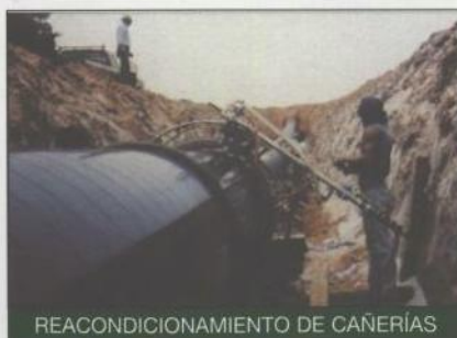
REACONDICIONAMIENTO DE CAÑERÍAS
