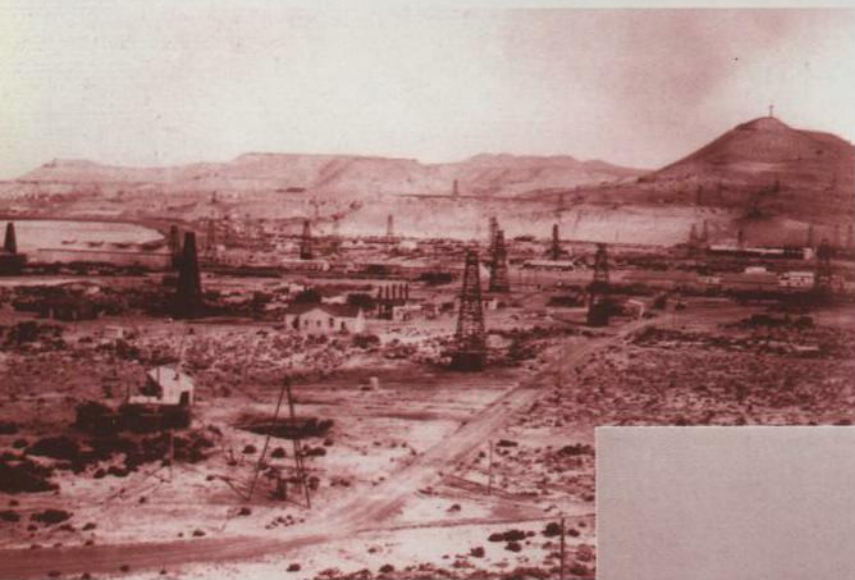
Zona de Kilómetro 4. Uno de los edificios centrales es seguramente una escuela, ya que varios chicos con guardapolvo están reunidos junto a la torre cubierta.
