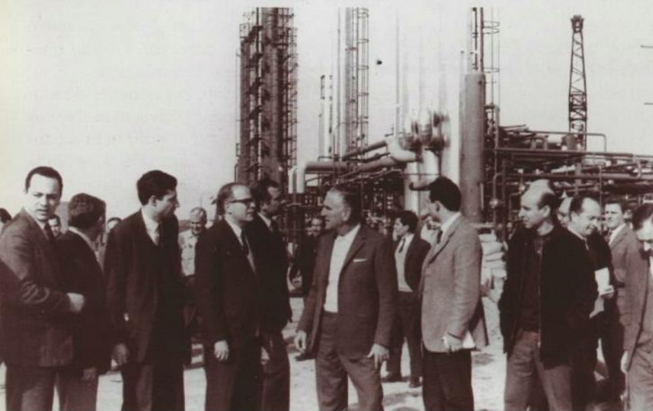
Inauguración de la planta cabecera del gasoducto Pico Truncado - Buenos Aires.
