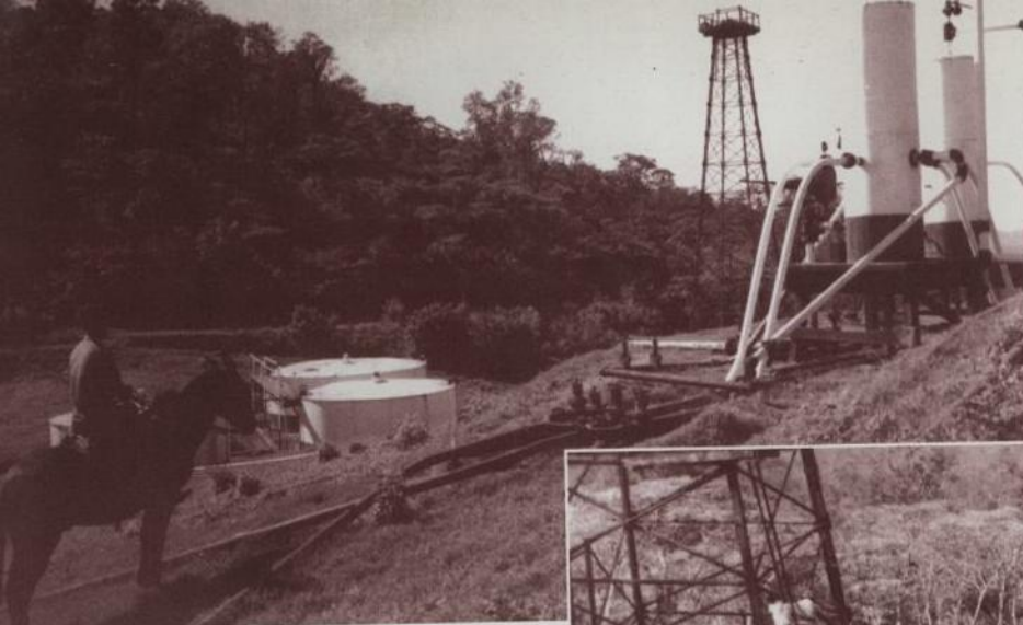
Separadores de gas y tanques de almacenamiento de Campamento San Pedro. Standard Oil Co. SA. Arg. (Tartagal, Salta)
