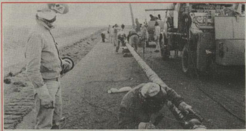
Los 161 km. de recorrido del oleoducto demandará 14.000 soldaduras previas al tendido y posterior cubrimiento por 1m. de tierra.
