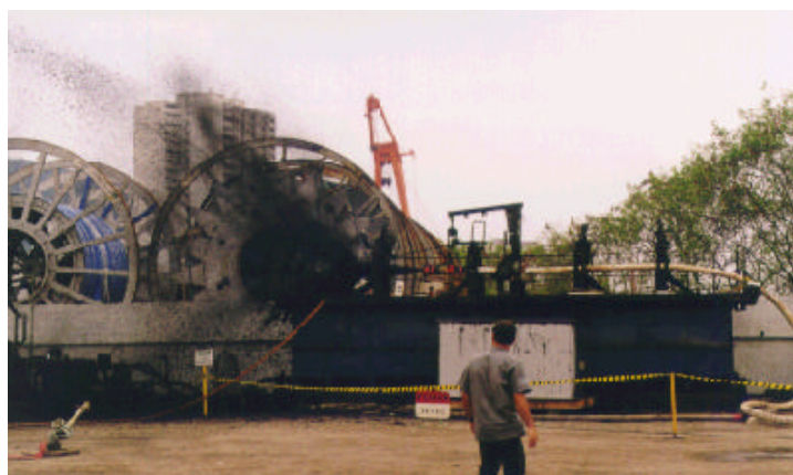
Figura 3 - Desobstrução no primeiro teste
