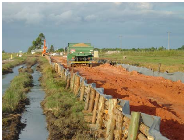
Figura 1. Estruturas implantadas para evitar o carreamento de sólidos
