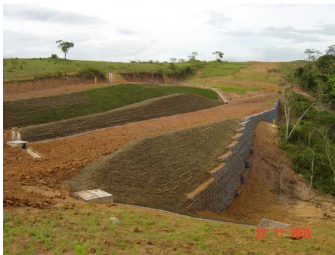
Figura 3. Execução de recomposição vegetal em taludes.
