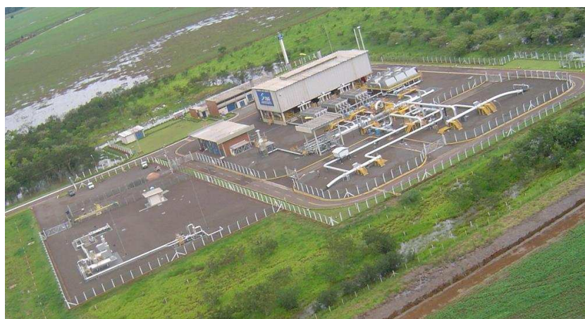
Figura 1.1 – Vista aérea da Estação de Compressão de Campo Grande - MS.
