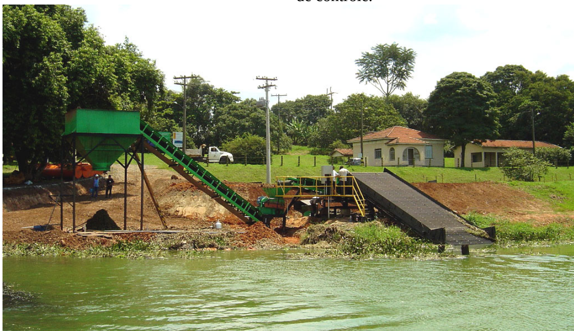
Figura 15. Equipamento de coleta e fragmentação de plantas em funcionamento.
