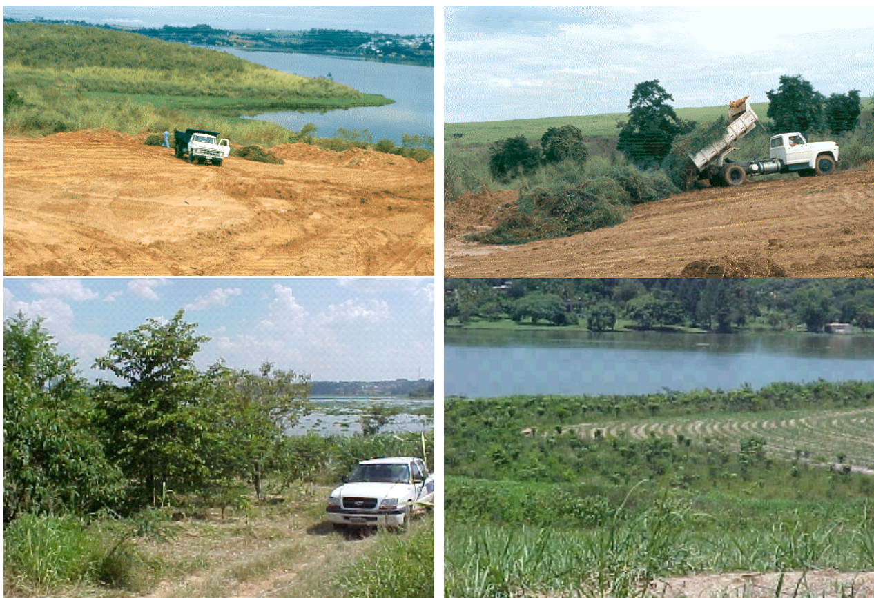
Figura 16. Área liberada para depósito das plantas aquáticas do reservatório de geração de energia da CPFL e o resultado da implantação da revegetação.
