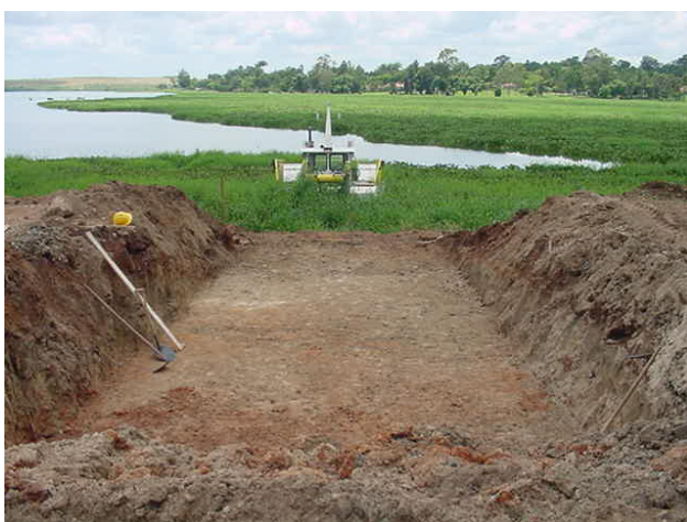
Figura 9. Preparo do terreno para instalação do sistema de coleta e fragmentação de plantas aquáticas.
