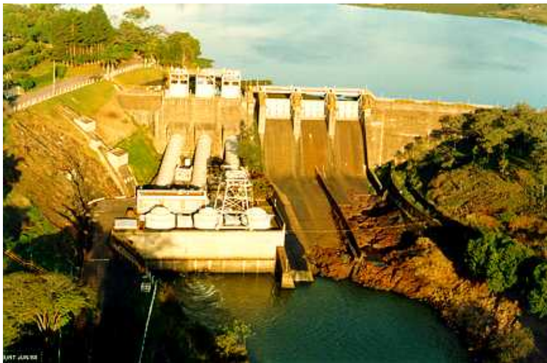
Figura 1. Usina Hidrelétrica Americana.
