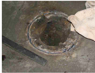
Figura 10 - Final etapa soldadura
