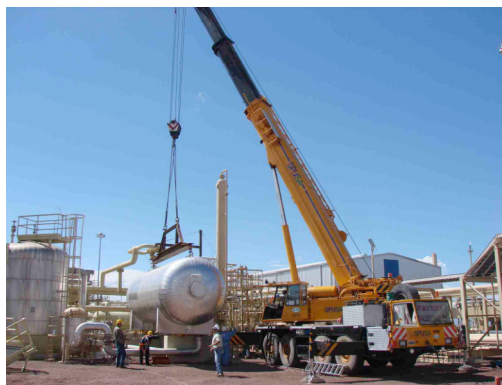
Figura 30 – Montaje de Flash Tank
