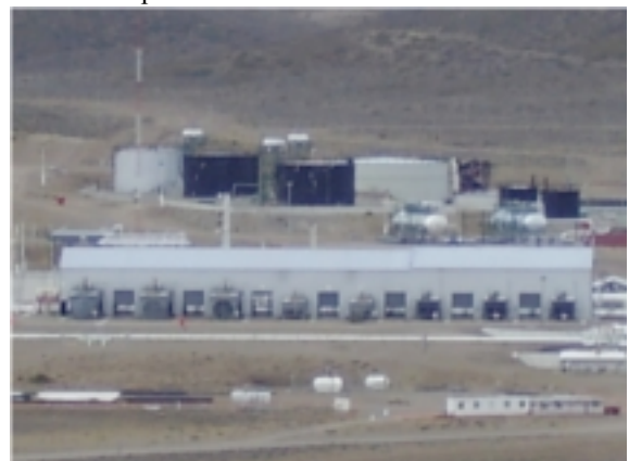
Fig. 5: Planta Compresora Zorro 1 - 2
