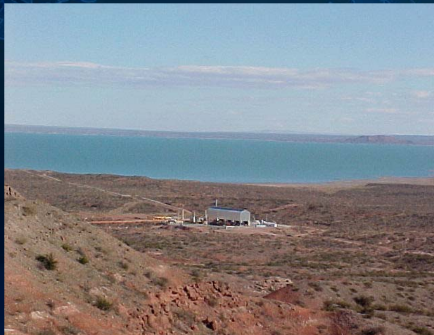
Vista panorámica Estación Compresora
