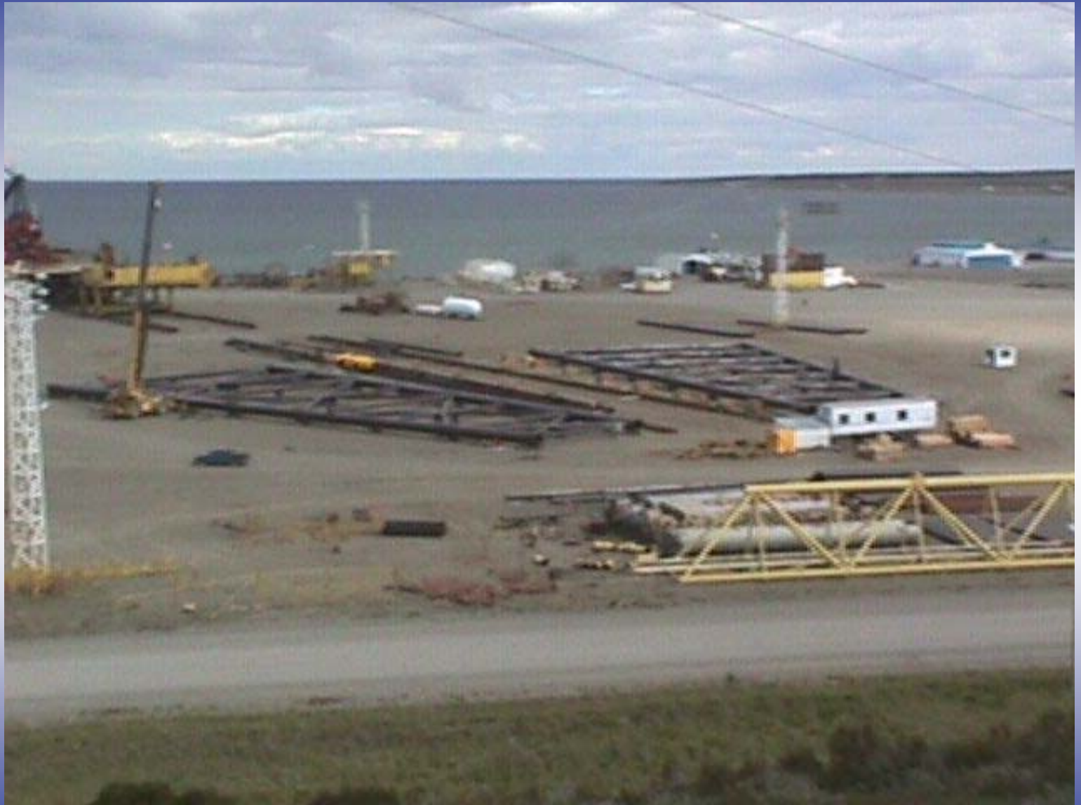
Construcción de Jacket en Bahía Laredo
