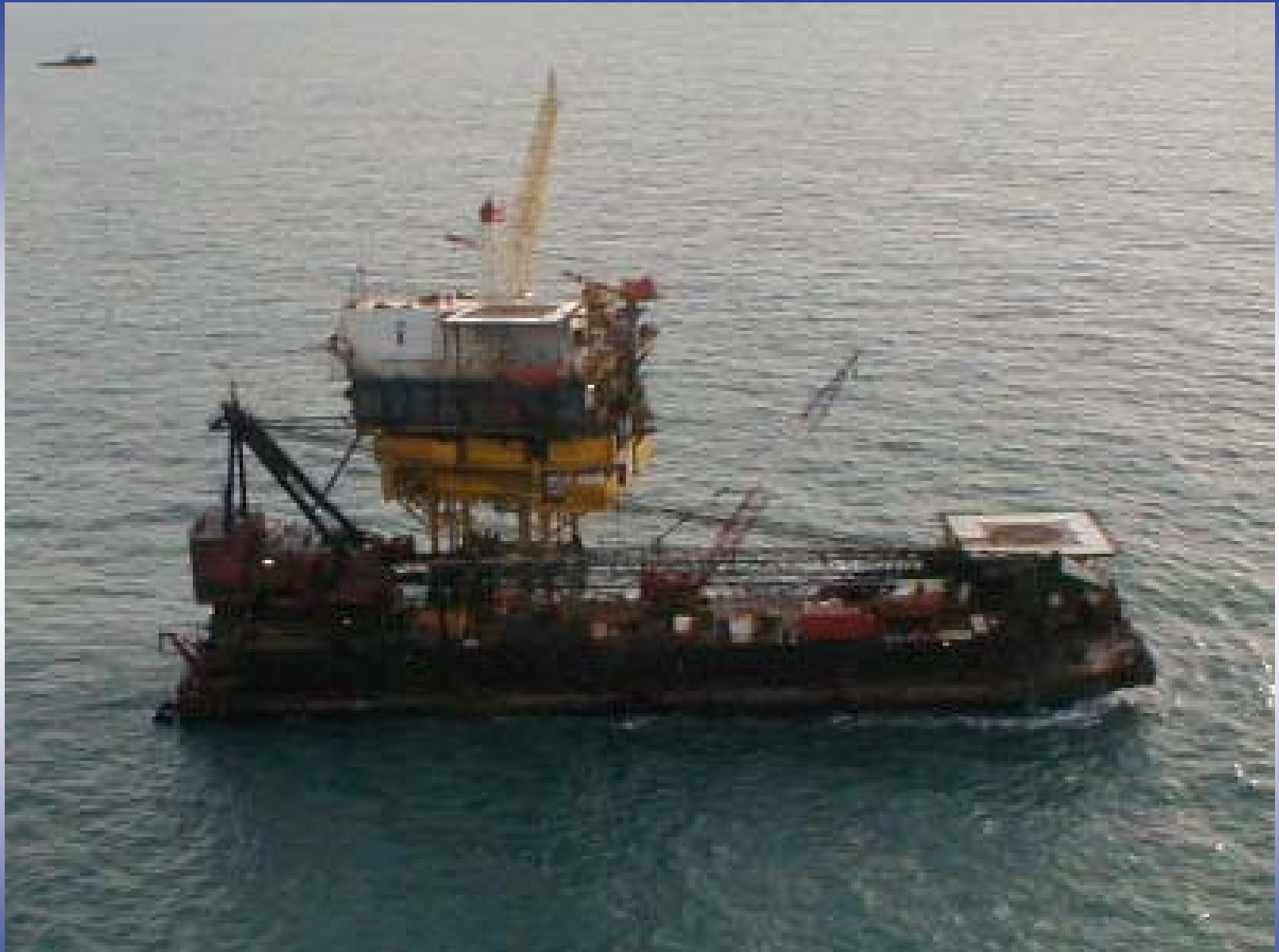
Montaje Equipo Perforación
