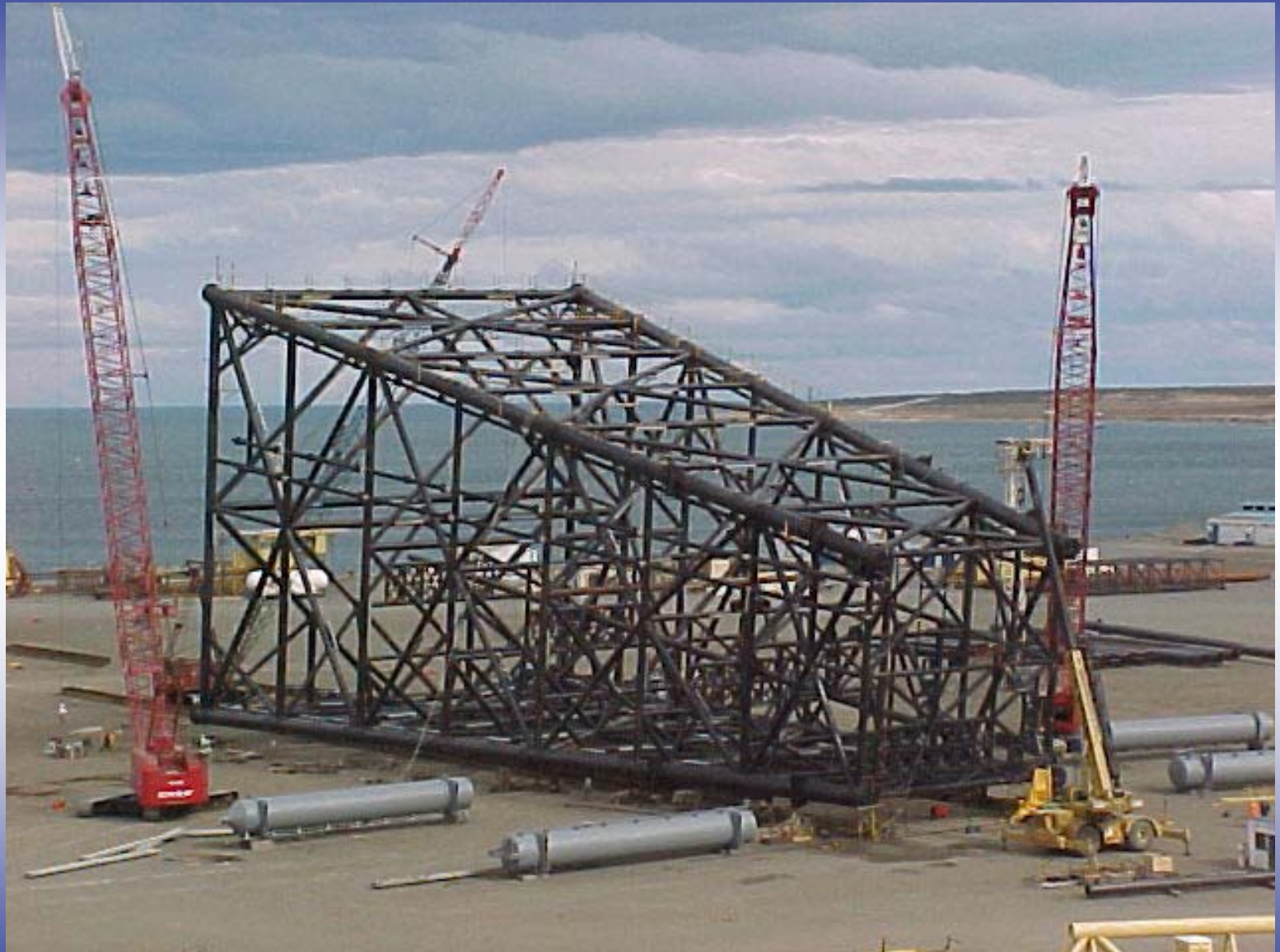
Instalación flotadores
