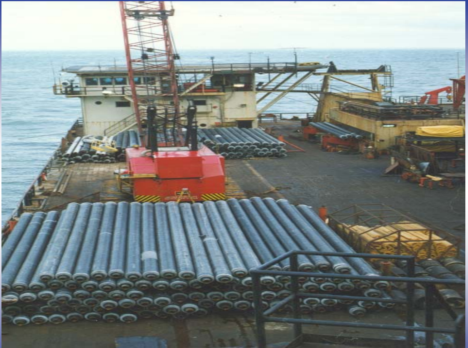
Almacenamiento tubería en cubierta
