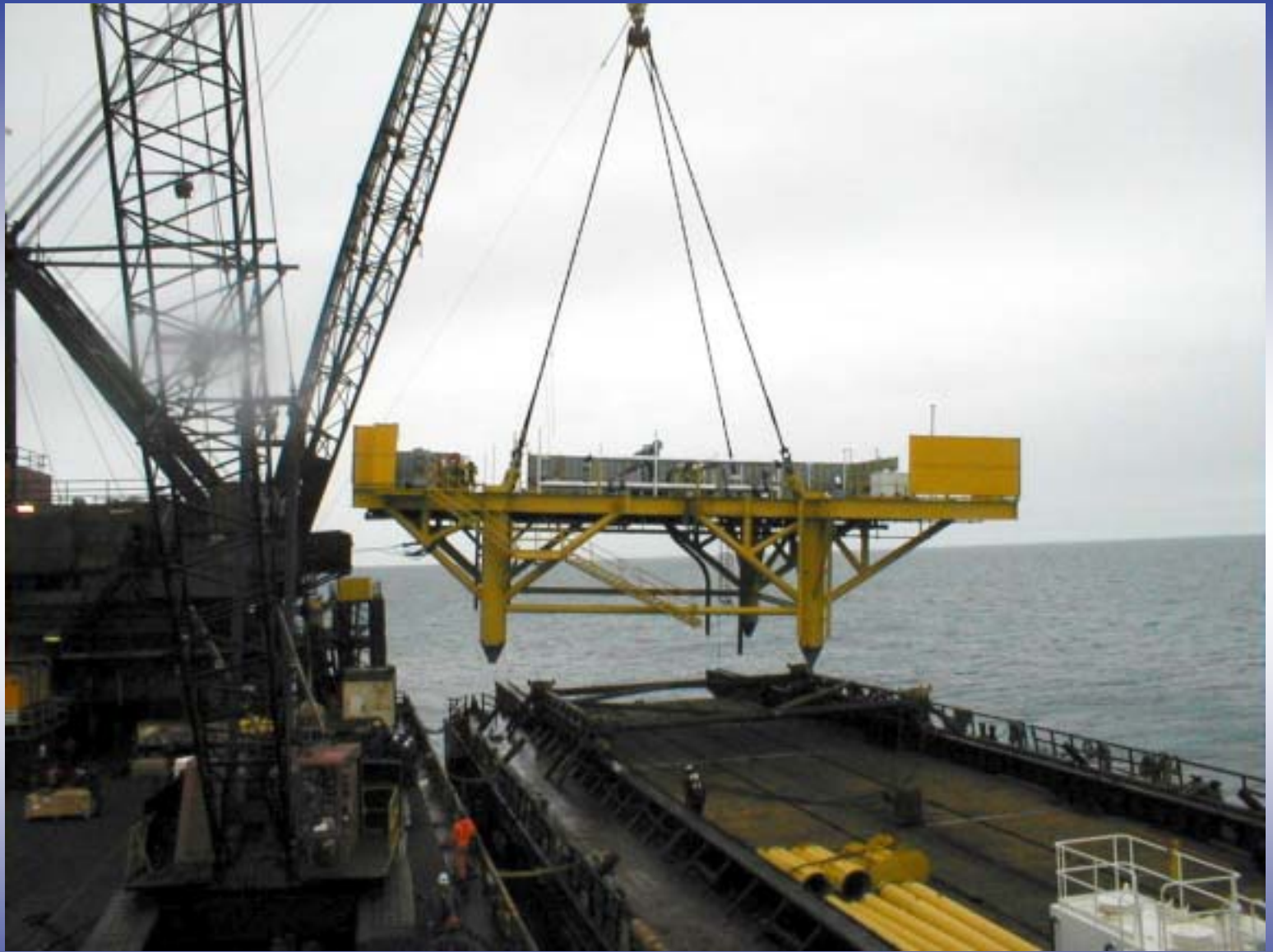
Montaje cubierta producción
