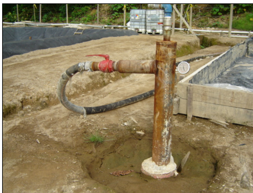
Foto 3: Instalación final de un pozo inyector tipo, listo para recibir el agua para disposición final.
