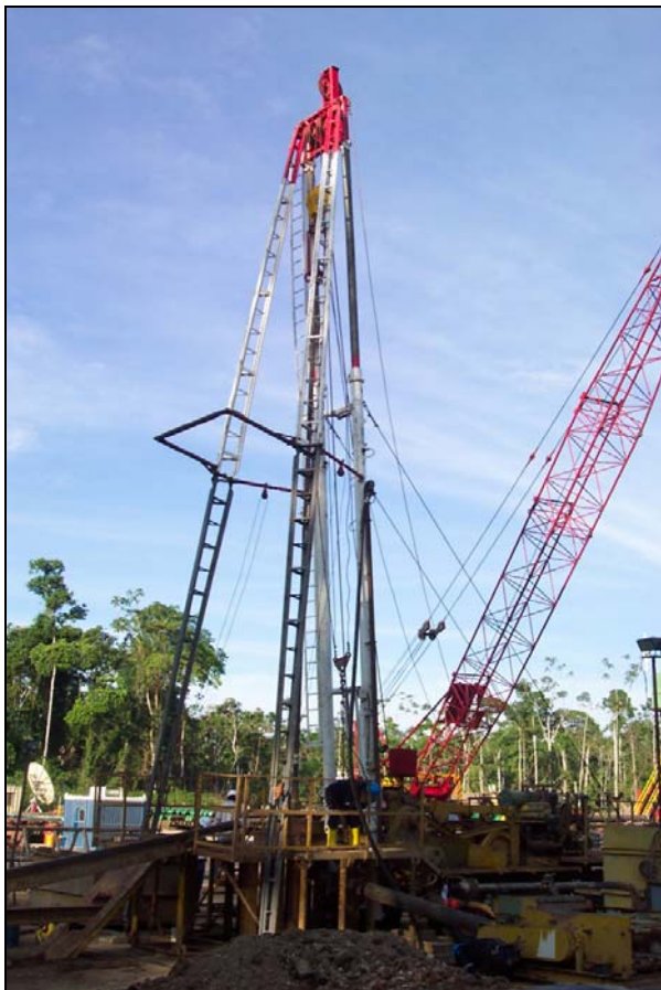
Foto 1-2: Equipo Rotary para agua, durante la perforación y entubación de un pozo Inyector
