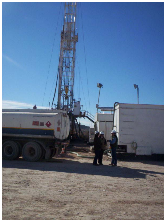
Foto N° 1 : Inspección en construcción pozo Ce-1177 en junio 2005
