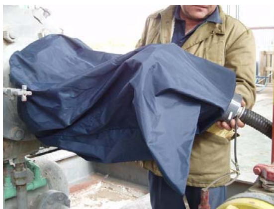
Foto 3. Personal técnico realizando mediciones con el equipo Hi Flow Sampler en válvula de un motocompresor de la planta de compresión perteneciente a la planta de tratamiento de gas del yacimiento Los Cavaos.
