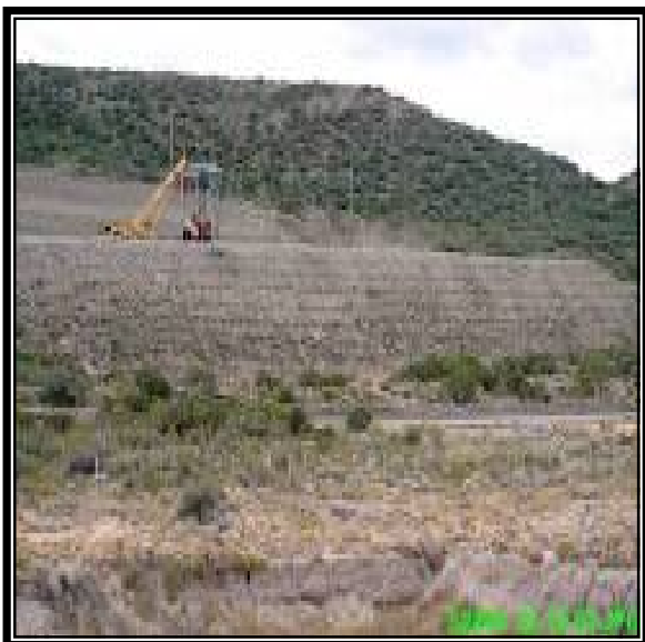
Locación con riego por goteo Diciembre 2003
