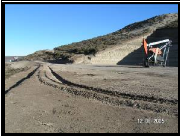
Locación con canaleta de drenaje
