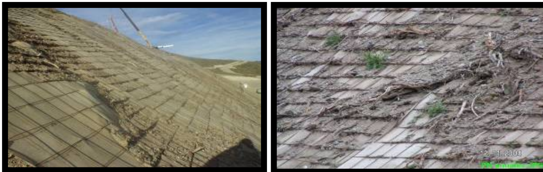
Biomanta de yute (arpillera 8oz) con sujeción de malla cima. Plantas asomando.
