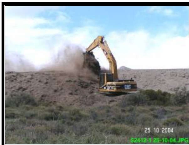
Distribución con retro de TS acopiado al pie
