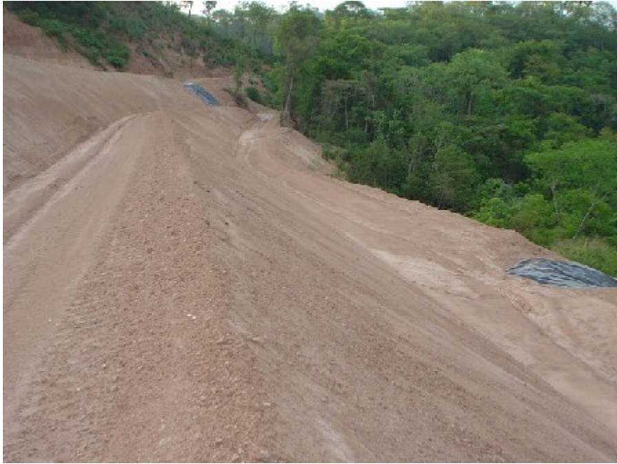
Foto 1: Estabilización de suelos: aterrazado. Clásico aterrazado de taludes artificiales construidos en relleno, en este caso de una locación. Estas terrazas son compactadas con contrapendiente hacia el talud y pendiente longitudinal de escurrimiento hacia los desagües, de los que se alcanzan a ver 2 de ellos. En esta imagen se ve el trabajo de movimiento de suelo recién concluido; inmediatamente posterior a esta etapa se procede a las tareas de revegetación.
