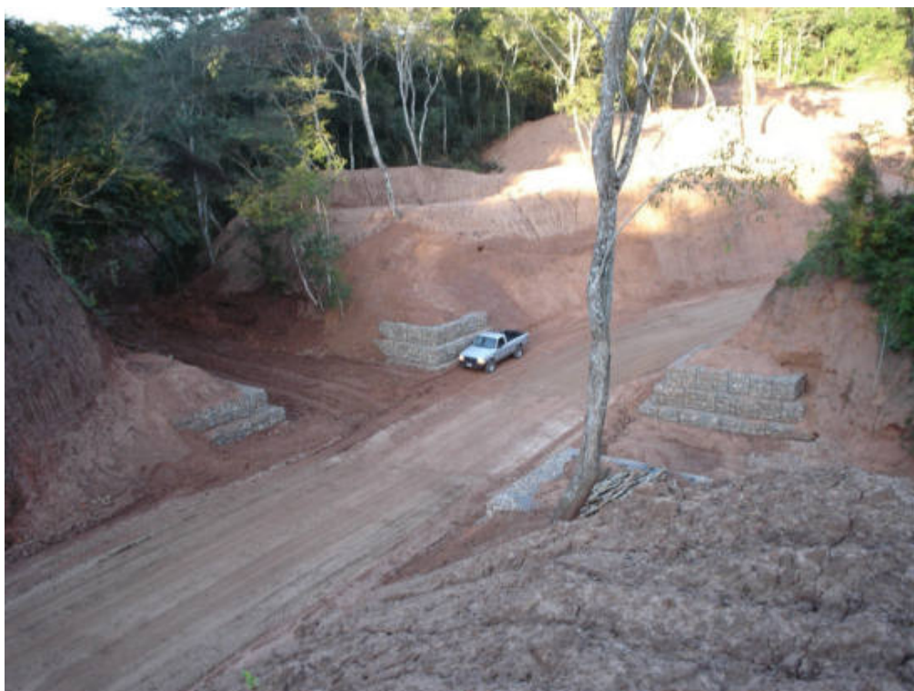
Foto 3: Badén y muros de contención. Se trata de una obra de cruce de quebrada a través de un badén construido con colchonetas de gaviones y hormigón armado. En las esquinas vemos muros de protección de taludes contra la embestida del agua, que a su vez cumplen la función de contención de los mismos taludes para evitar su colapso ante la saturación durante una tormenta. A su vez la foto está sacada desde una terraza para estabilizar el corte cajón que debió realizarse.
