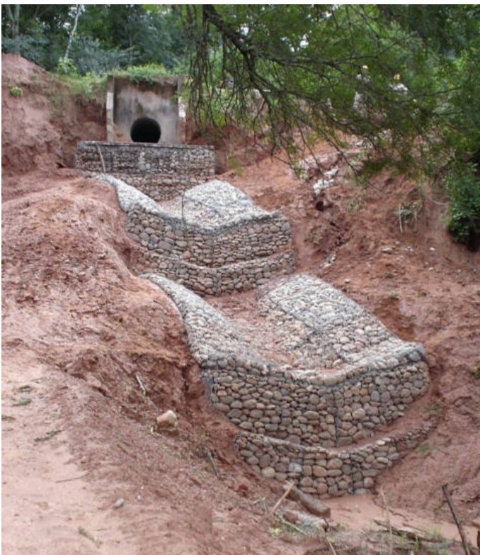
Foto 8: Salto hidráulico y obra de desagüe. Vemos un pequeño salto hidráulico como obra de descarga a la salida de una alcantarilla vial cubriendo un importante desnivel hasta la quebrada principal. Posteriormente se revegetaron los taludes.
