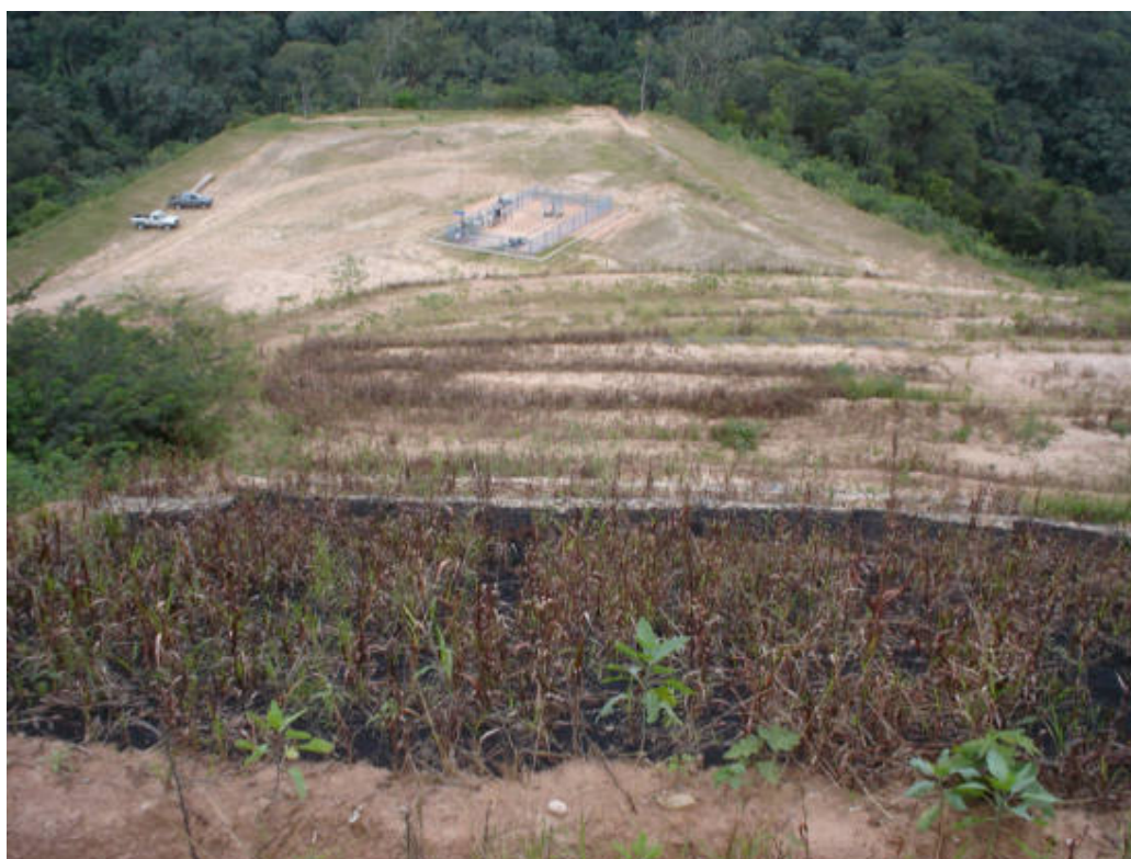
Foto 10: Revegetación de taludes. Mismo talud que foto 9, ahora visto desde arriba y poco tiempo después cuando recién había comenzando el proceso de revegetación.
