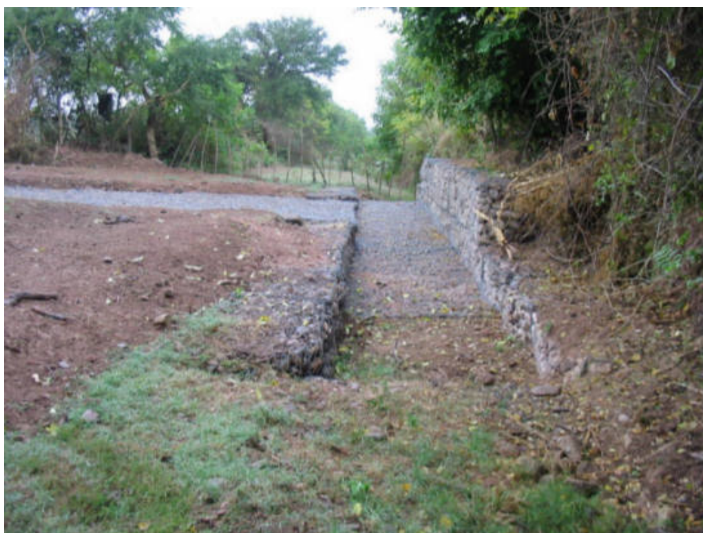
Foto 4: Deflector, obra de conducción y disipación de energía. En esta pequeña obra vemos una obra de canalización que a su vez redirige el caudal que es aportado desde la izquierda. Ambos caudales terminan en una pileta que intenta reducirle la energía al agua.
