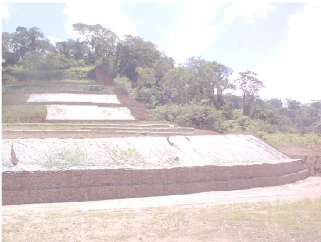
Foto 9: Revegetación de taludes. Luego del estabilizado del talud mediante aterrazado y muros de contención, se procedió a revegetar con suelo natural reforzado con semillas debidamente seleccionadas por especialistas. También se utilizaron distintos tipos de mantas de control de erosión, en función principalmente de la pendiente, para facilitar el crecimiento de la vegetación.
