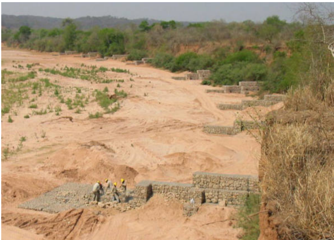
Foto 6: Protección de margen de cauce. Es el mismo caso de la foto anterior pero a gran escala. En esta oportunidad se optó una sucesión de espigones que intentan separar el agua de la margen, y a su vez permiten la progresiva deposición de material de arrastre, fortaleciendo la orilla.
