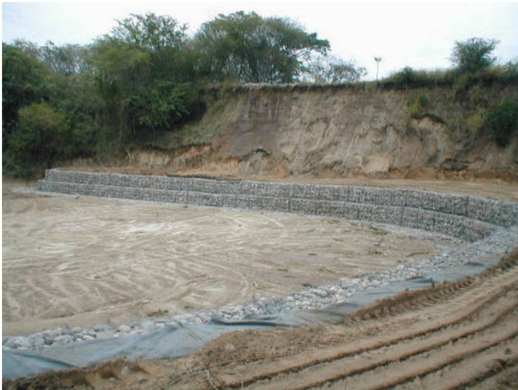
Foto 5: Protección de margen de cauce. Suele ser necesario proteger algunos tramos de márgenes de cauces inestables para que la erosión no continúe avanzando (hacia el exterior de la curva) poniendo en peligro instalaciones. En este caso se trata de un revestimiento completo de la curva.
