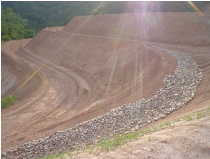
Foto 2: misma locación y etapa que foto 1. Se observa un empedrado para aumentar la rugosidad del terreno en un tramo de fuerte pendiente para evitar la erosión del agua. Debajo se coloca malla geotextil sobre la cual se apisonan las piedras.
