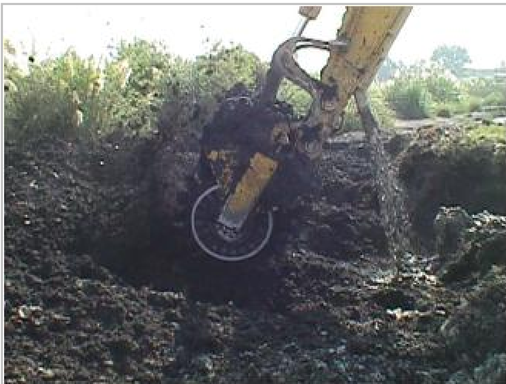
Foto 4: Estabilización/solidificación en operación continua utilizando retroexcavadora con rodillo hidráulico y reactivos mezclados con agua.
