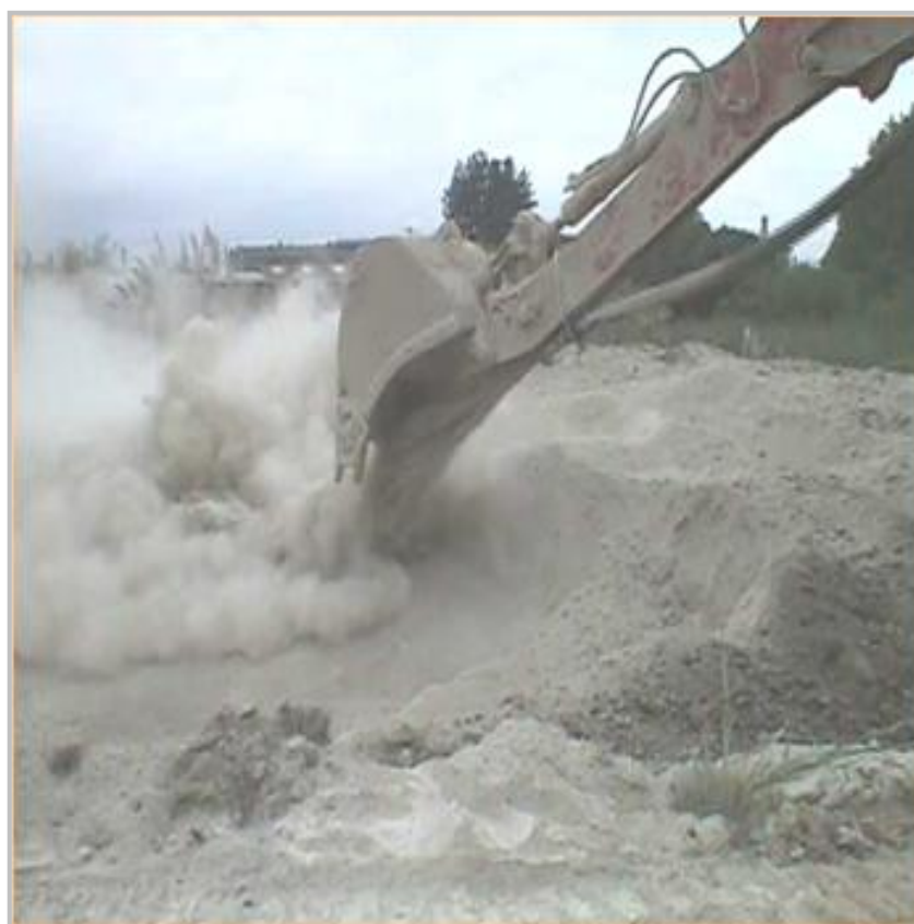
Foto 2: Aplicación de estabilización/solidificación en operación continua utilizando retroexcavadora y reativos en seco.
