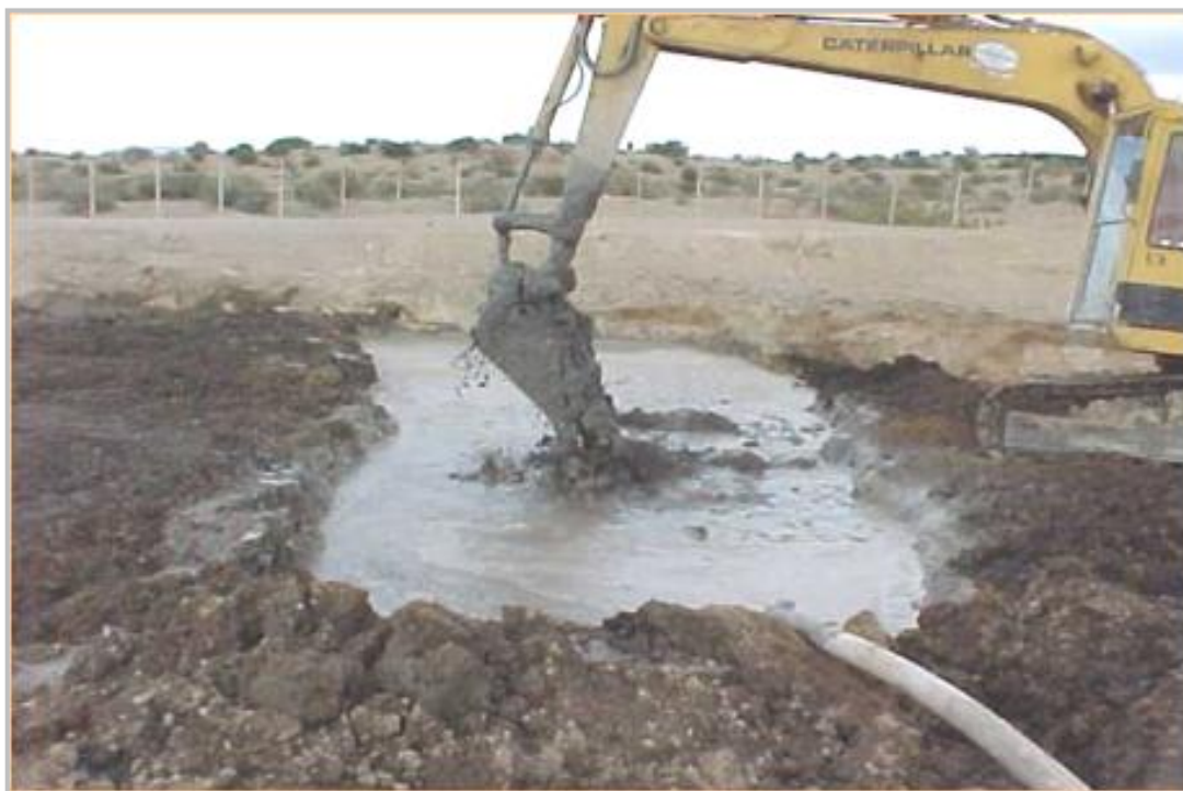
Foto 1: Aplicación de estabilización/solidificación en operación discontinua utilizando retroexcavadora y reactivos mezclados con agua.
