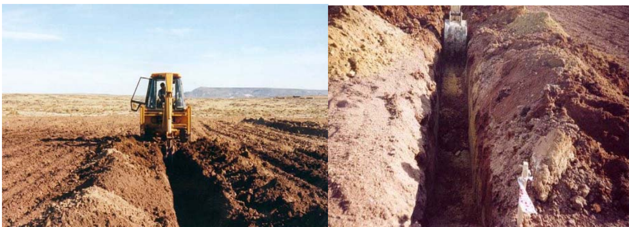
Figuras 3 y 4. Vista del armado de las zanjas de drenaje.
