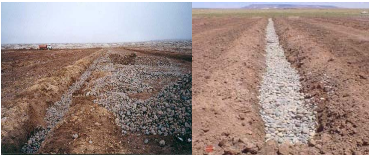
Figuras 5 y 6. Vista del armado de los lechos filtrantes y drenajes.
