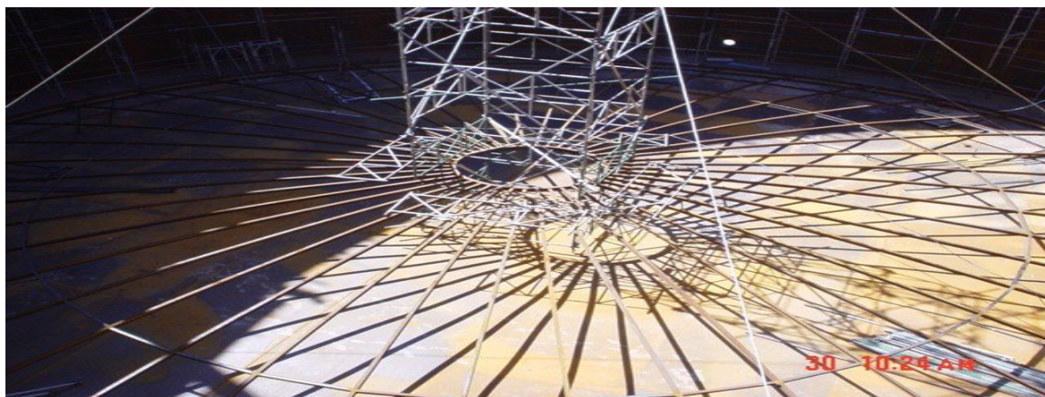
Vista en etapa de construcción - Estructura soporte de la membrana interna del gasómetro
