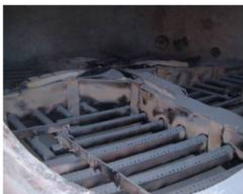
Foto 5: Reemplazo de grilla de aire del regenerador. Nueva grilla de aire (derecha)
