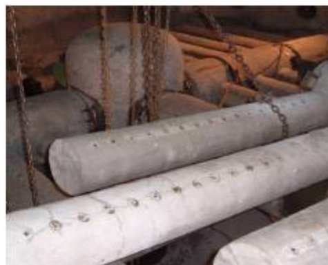
Foto 5: Reemplazo de grilla de aire del regenerador. Nueva grilla de aire (derecha)
