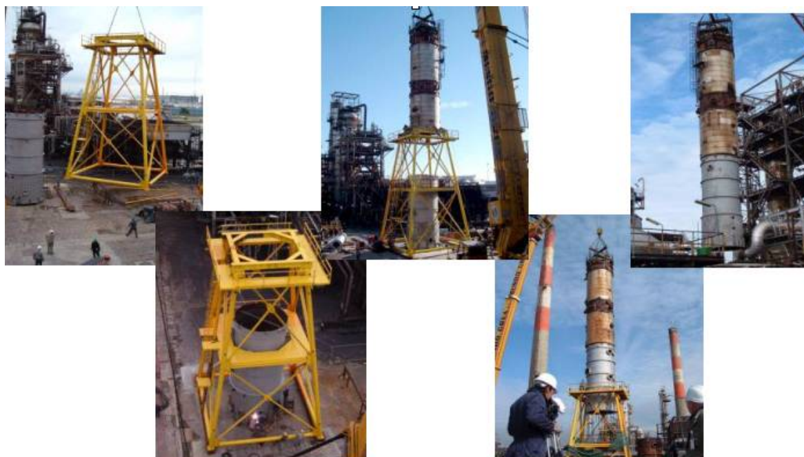
Foto 7: Secuencia de los izajes en el reemplazo del fondo de la C-321.
