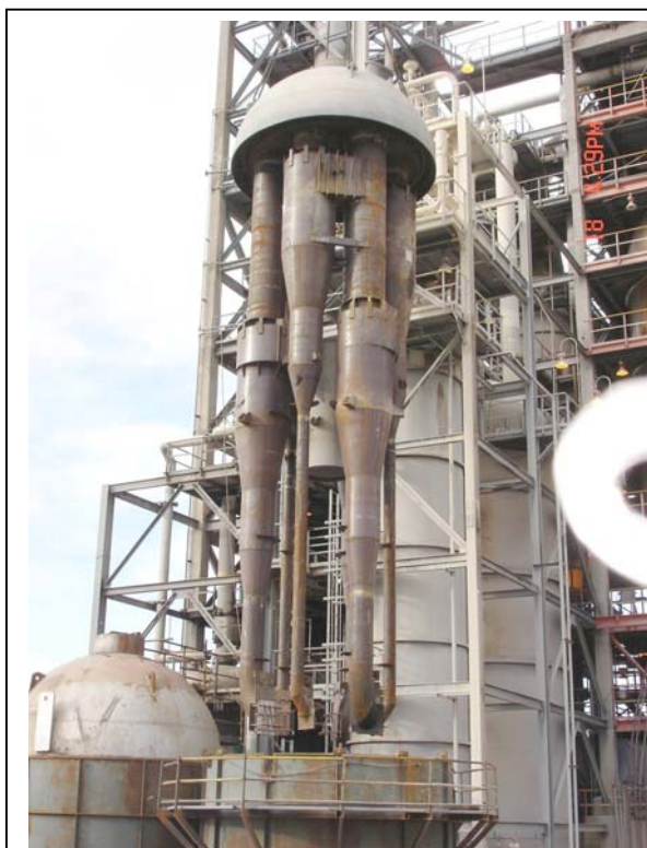
Figura N°5 : Montaje conjunto nuevo diseño
