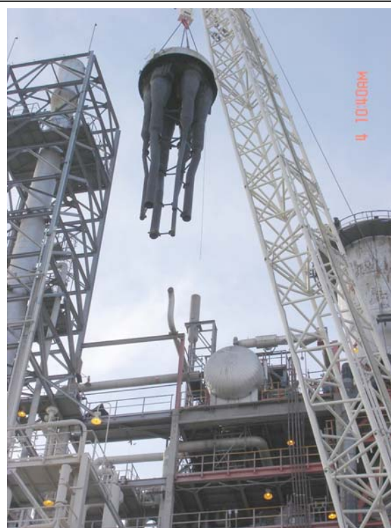
Figura N°6 : Desmontaje conjunto a sustituir
